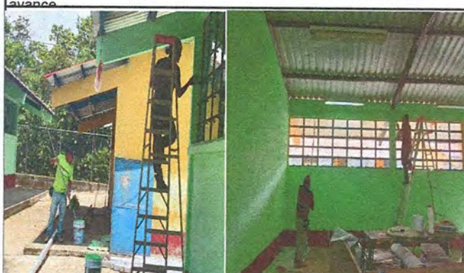
Foto 4: Pintado de los interiores y exteriores del centro educativo con un avance del 70%
