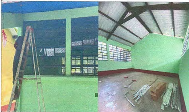
Foto 3: Mejoramiento y colocación de vidrios de ventanería e instalaciones eléctricas con un avance del 70%
