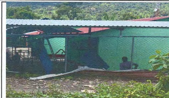
Foto 1: Vista general en el centro educativo con un avance del 70%
