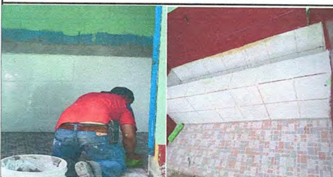
Foto 5: Reparación y mejoramiento de los Servicios Sanitarios con un avance del 70 %
